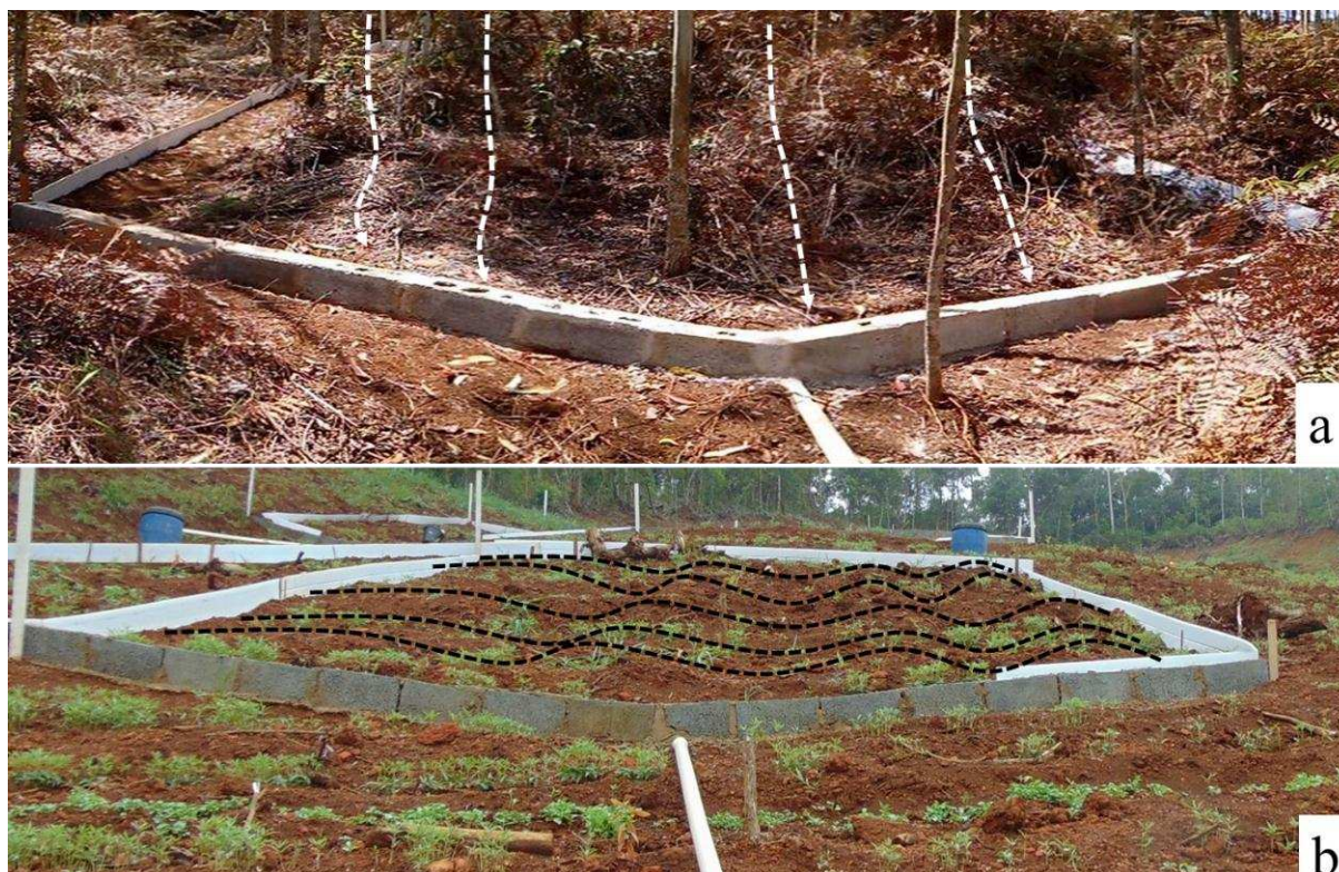
Figura 16. Rugosidade no sentido do declive antes da mineração representada pela linha branca tracejada (a); em nível após mineração e reconformação da superfície na reabilitação inicial representada pela linha preta tracejada (b), no município de Rosário da Limeira, Minas Gerais.
