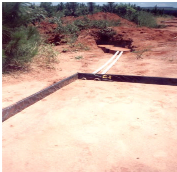
Figura 6 – Instalação dos tambores coletores.
