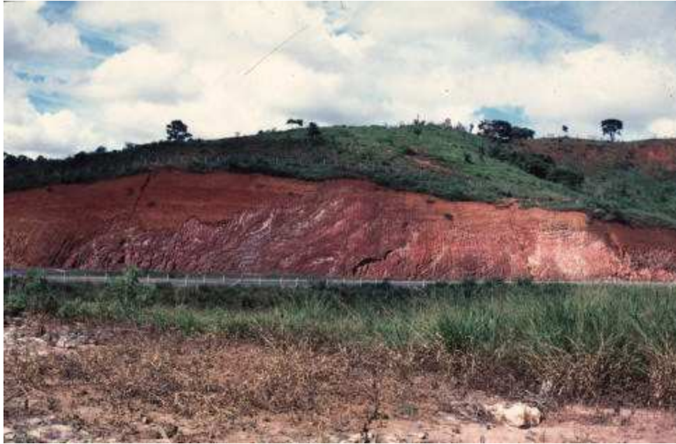
Figura 4 - Talude da Usina de Lixo sem cobertura vegetal e com grande variação na cor do solo - município de Viçosa, MG.
