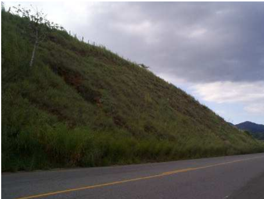
Figura 7 - Talude São Geraldo B, com manchas de solo exposto na área onde ocorre o capim-gordura ( Melinis minutiflora ) - município de São Geraldo, MG.
