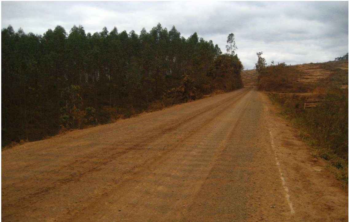
Figura 5 - Estrada Florestal coberta com revestimento primário
