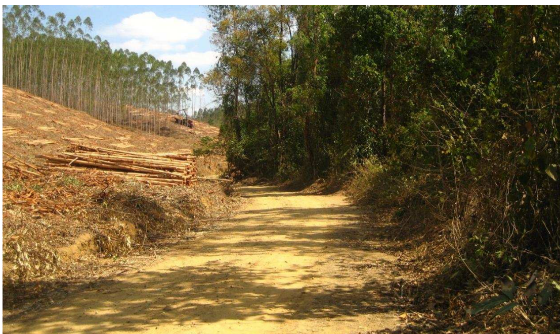
Figura 6 - Estrada Florestal sem revestimento
