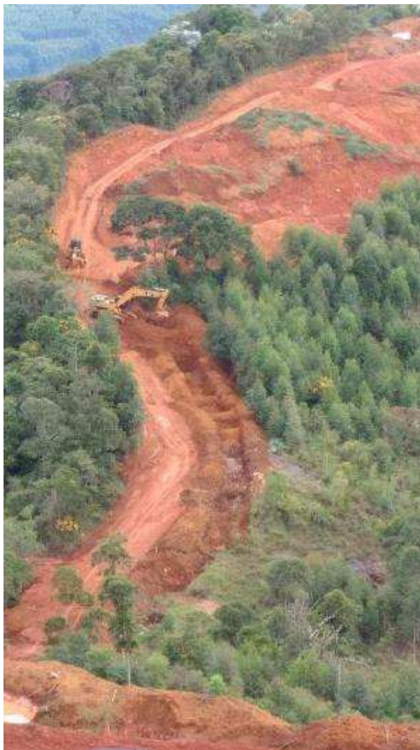
Figura 20 - Manutenção nos poços de decantação e fechamento de acesso de um corpo de mineração de bauxita. Rosário da Limeira-MG, 2017.
