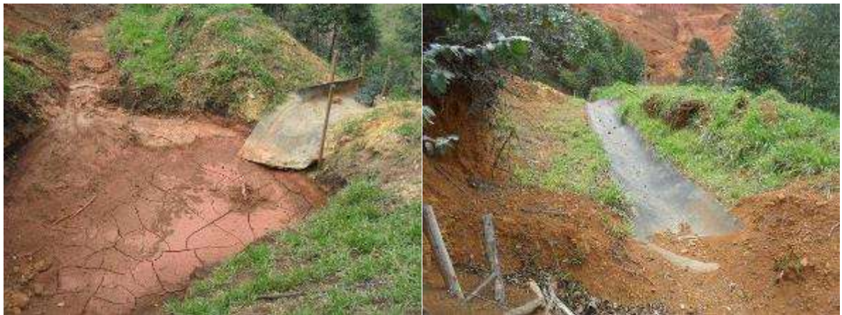
Figura 18 - Uso de correias transportadoras no controle de processos erosivos em áreas de exploração de bauxita. Rosário da Limeira-MG, 2017.
