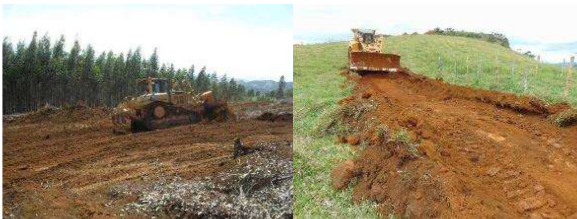
Figura 12 - Decapeamento do solo com a utilização de trator de esteiras. Rosário da LimeiraMG, 2017.
