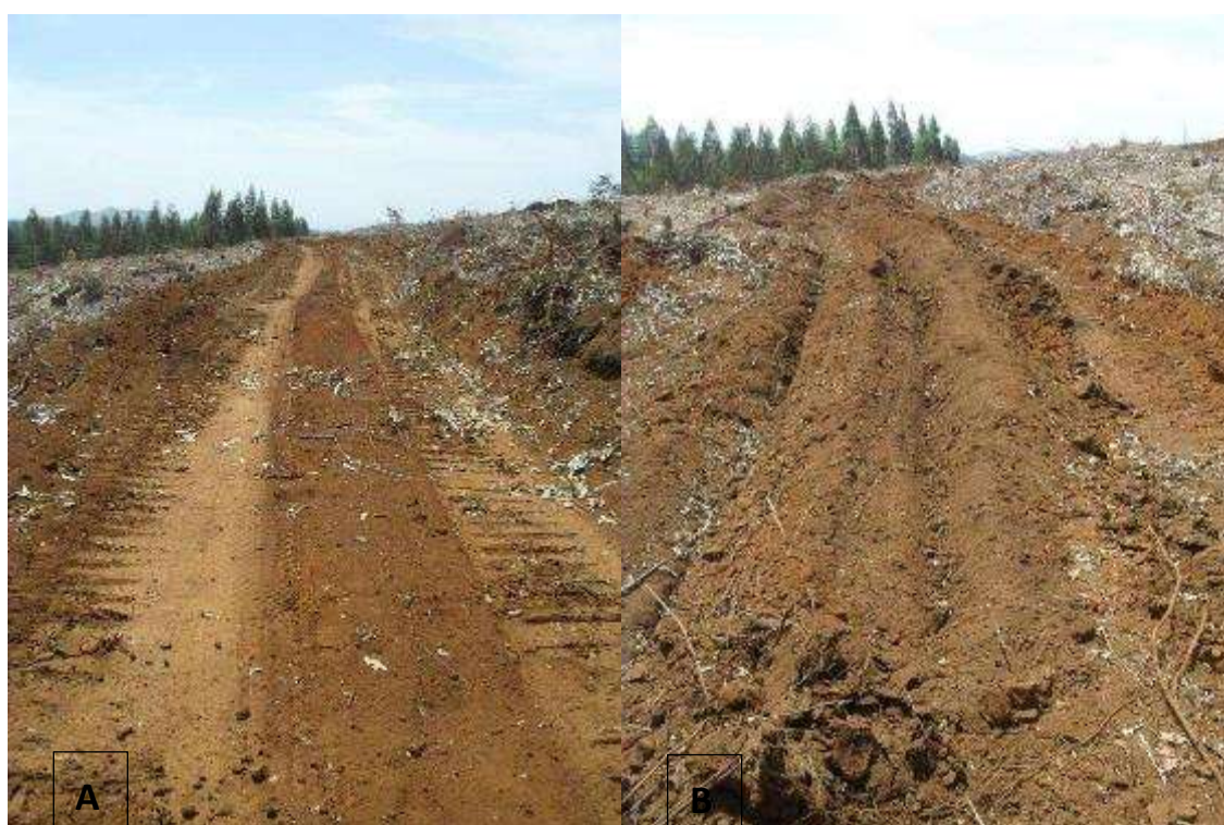
Figura 11 - Etapas executadas após o corte do eucalipto. A) Estrada de acesso para a retirada da madeira. B) Estrada escarificada após a retirada da madeira. Rosário da Limeira-MG, 2017.
