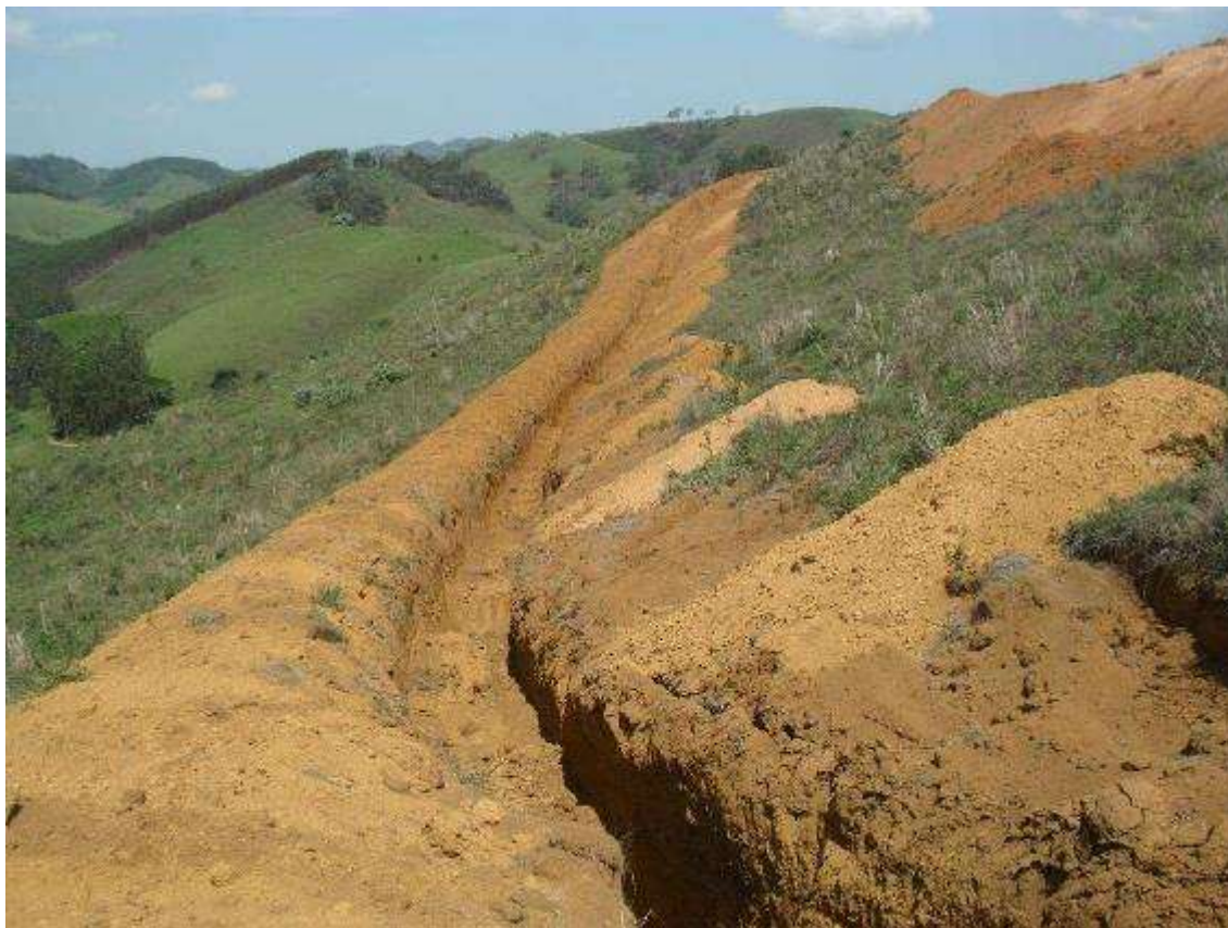
Figura 21 - Trincheira para retenção de água de escoamento superficial e material sólido em área de exploração de bauxita. São Sebastião da Vargem Alegre-MG, 2017.
