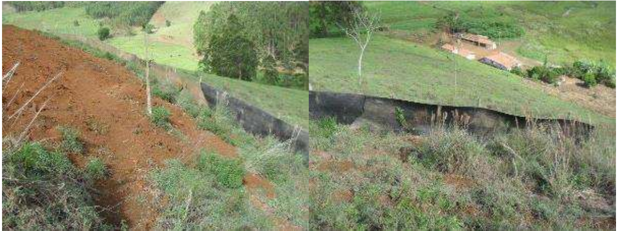
Figura 19 - Uso de correias transportadoras para contenção de material sólido em áreas de exploração de bauxita. Rosário da Limeira-MG,2017.
