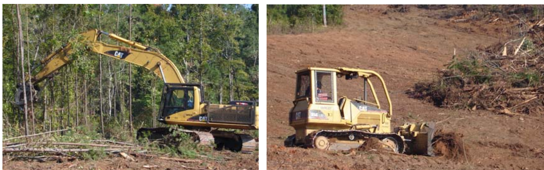
Figura 1. Escavadora hidráulica Caterpillar 330C e trator de esteiras Caterpillar D5G.
