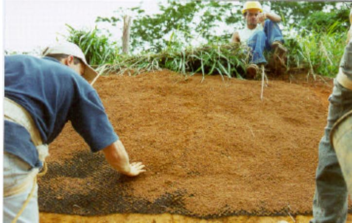
Figura 2 – Preenchimento da manta MacMat<sup>®</sup> com o substrato.
