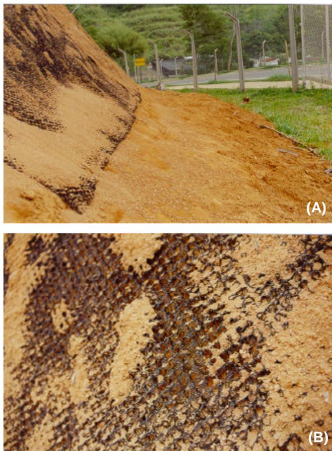
Figura 17 – Perda de solos na manta MacMat® (A) vista geral e (B) vista em detalhe.
