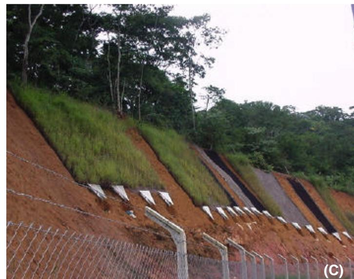
Figura 6 – Distribuição dos experimentos no talude da Via Alternativa. (A) e (B) Estabelecimento de vegetação, (C) Escoamento superficial.
