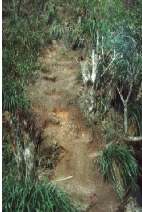
Figura 3 – Erosão em trilha interpretativa - Lavras Novas, Ouro Preto, Minas Gerais.
