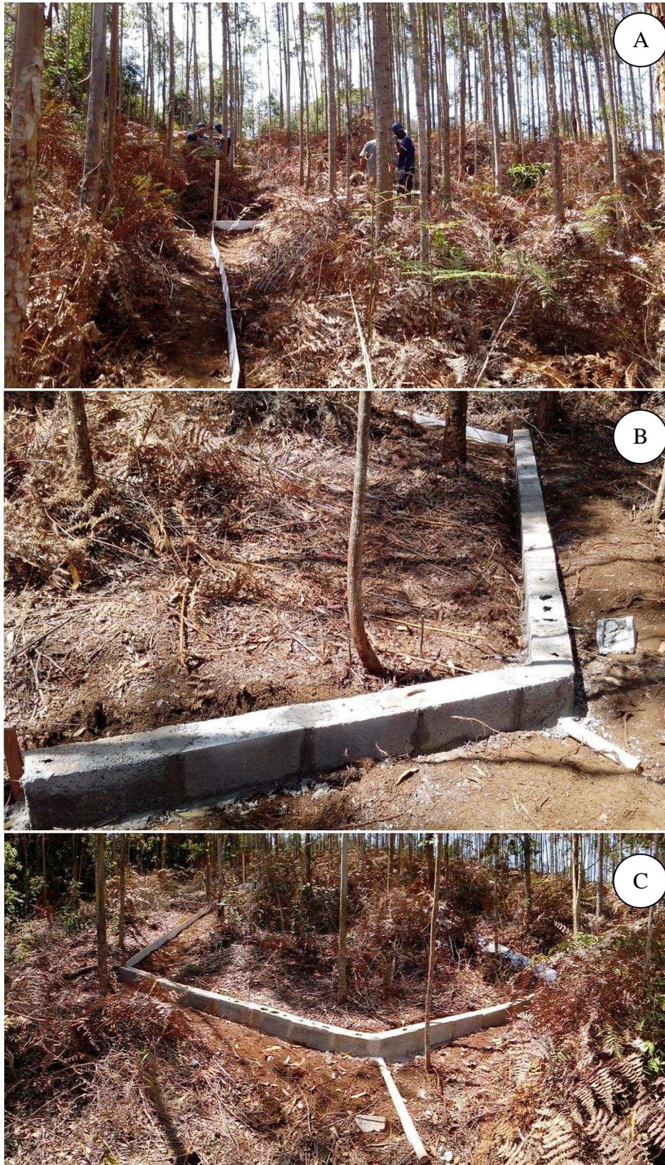
**Figura 9.** Parcelas coletoras de escoamento superficial da área pré-lavra, no município de Rosário da Limeira, em 27 de outubro de 2016. A) Instalação das placas de forro PVC. Nota-se a preservação da vegetação na parte interna da parcela; B) Detalhe da construção do afunilamento em alvenaria; C) Parcela nº 7 construída e a espera para instalação do recipiente de armazenamento do escoamento superficial.
