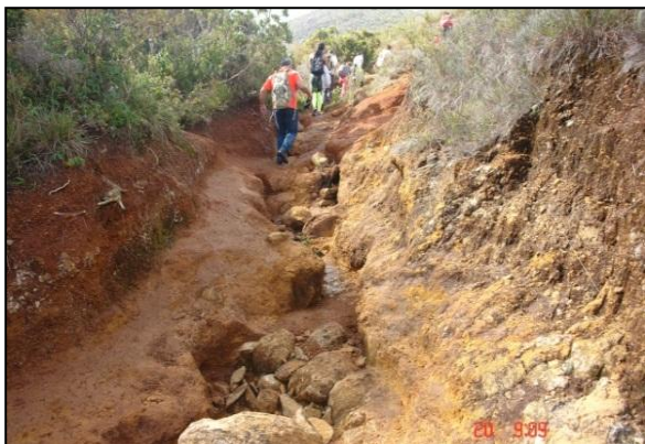
Fonte: foto tirada pelo autor (2015). Figura 9 – Erosão em sulco na trilha ao Pico da Bandeira a partir do Terreirão.
