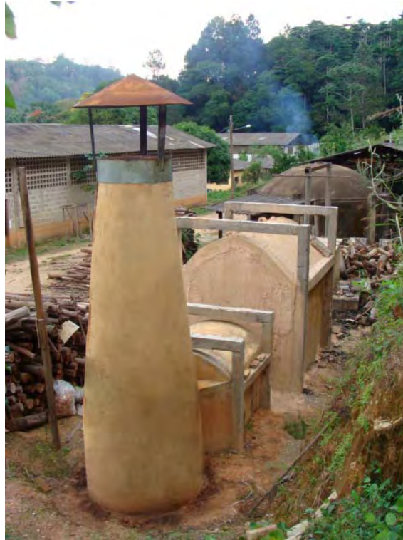
Figura 8 – Vista geral do projeto.
