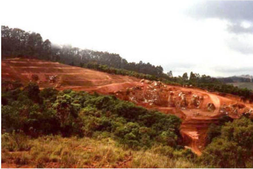
FIGURA 3: Reconstrução topográfica realizada nas áreas de mineração de bauxita, em Poços de Caldas – MG, pela ALCOA Alumínio S.A.
