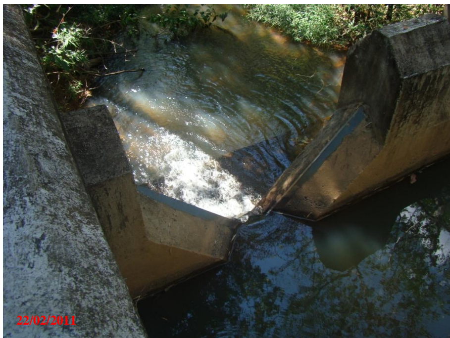
Figura 6 - Vertedouro triangular localizado na foz da Bacia Hidrográfica do Riacho Fundo, onde está instalado o Levellogger. Felixlândia - MG, 2011.
