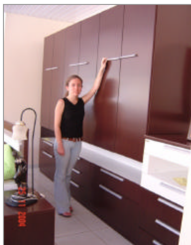
Figura 53 – Puxador da porta com altura superior ao alcance de uma pessoa considerada de menor proporção corporal.
