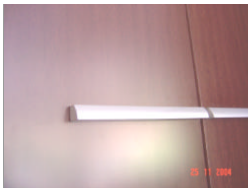
Figura 54 – Configuração do puxador que dificulta a apreensão da mão
