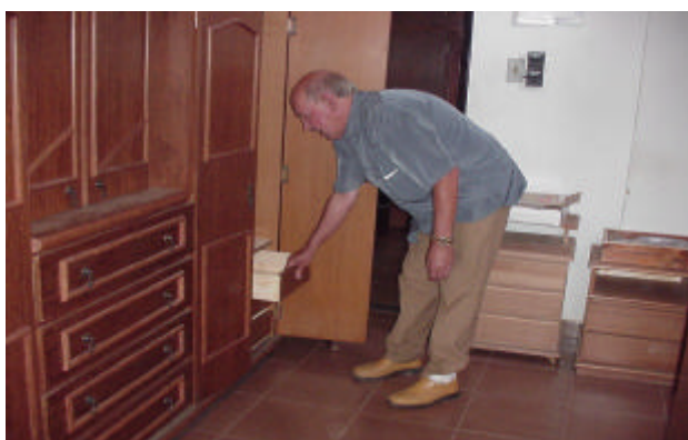
Figura 60 – Altura da gaveta muito baixa em relação ao piso
