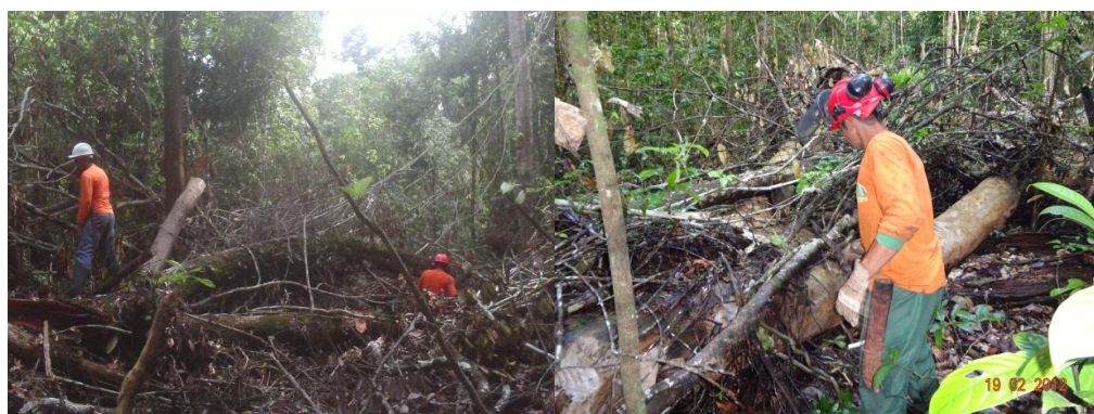
Figura 7. Ambiente em que os resíduos estão e a execução da limpeza no local.
