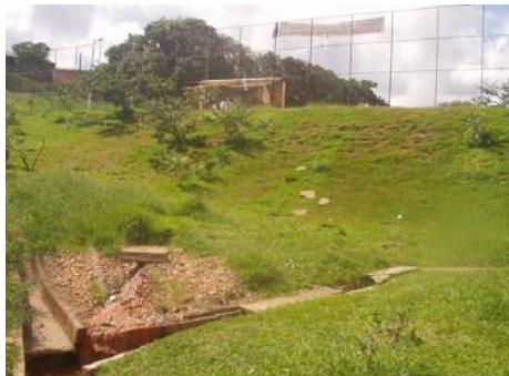
Figura 71 – Talude usado nas brincadeiras. Fonte: Arquivo do autor (nov. 2006).
