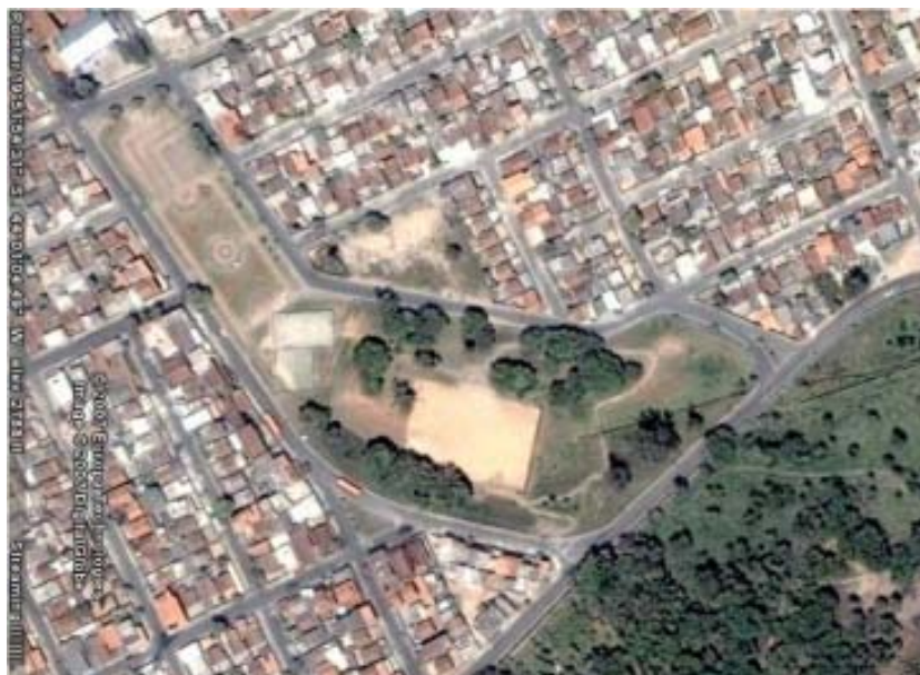
Figura 20 – Vista aérea do Parque do Confisco e seu entorno, capturada em maio de 2007. Fonte: Google Earth.
