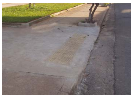
Figura 28 – Rampa na calçada. Fonte: Arquivo do autor (maio 2007).
