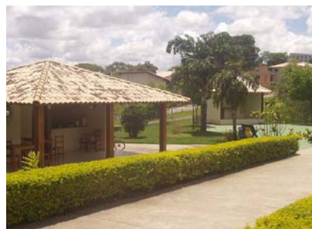
Figura 59 – Área de apoio/cozinha Fonte: Arquivo do autor (nov. 2006).
