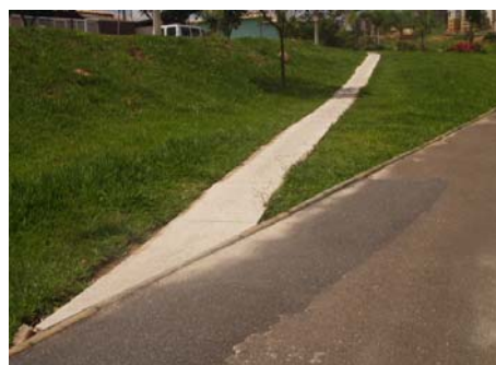
Figura 41 – Rampa de acesso Fonte: Arquivo do autor (nov. 2006).
