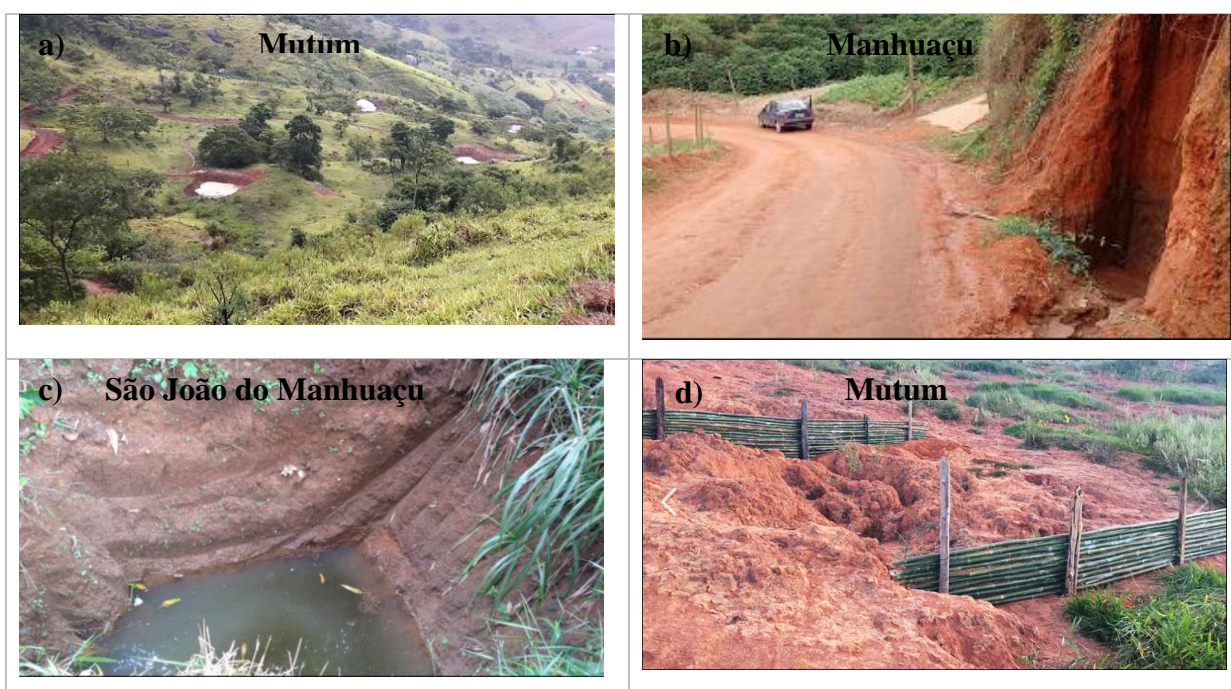
Figura 16: Práticas de conservação de solo e água na bacia hidrográfica do Rio Manhuaçu; (a,b, c) Bacia de captação de água pluvial de estradas; (d) contenção de voçorocas com paliçadas.
