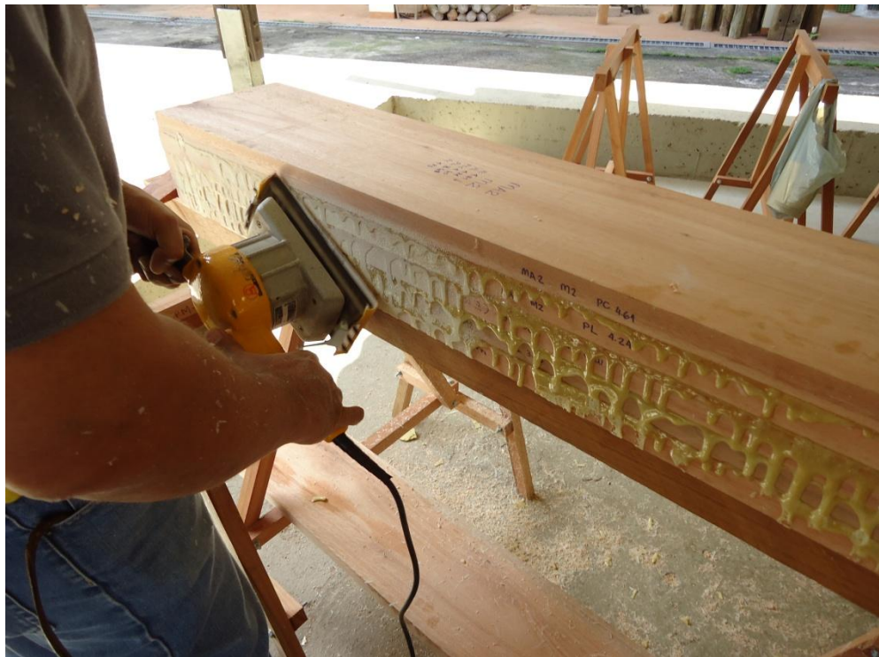
Figura 13 – Lixamento da superfície.
