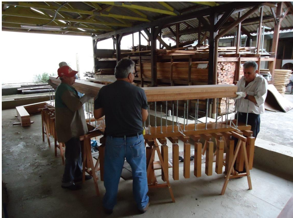
Figura 11 – Retirada da estrutura construída, do gabarito, para armazenamento.
