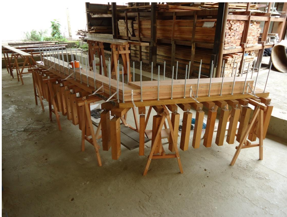
Figura 7 – Gabarito confeccionado para construção das estruturas.
