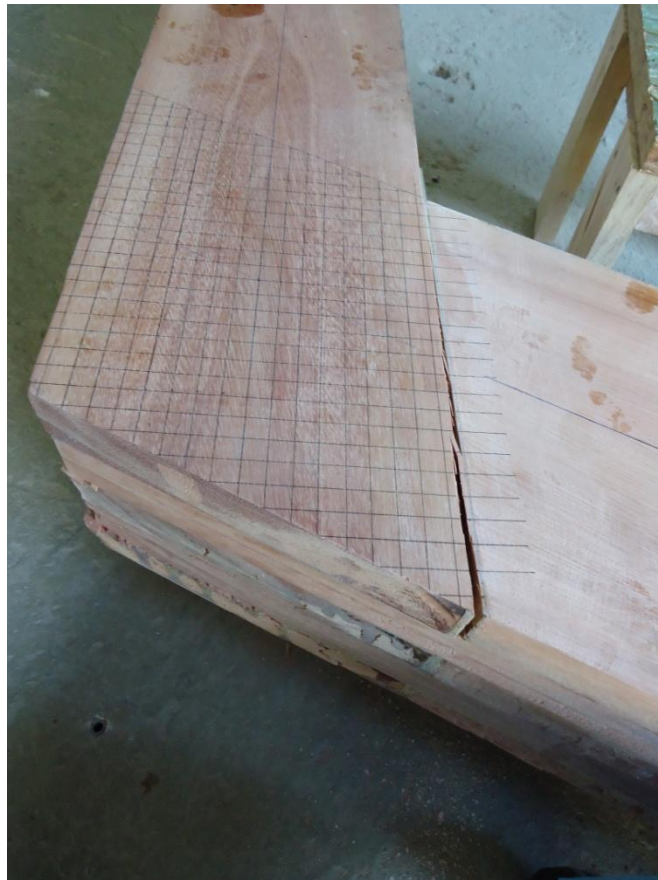
Figura 41 - Detalhe da ruptura ocorrida na região do nó B da estrutura M2.
