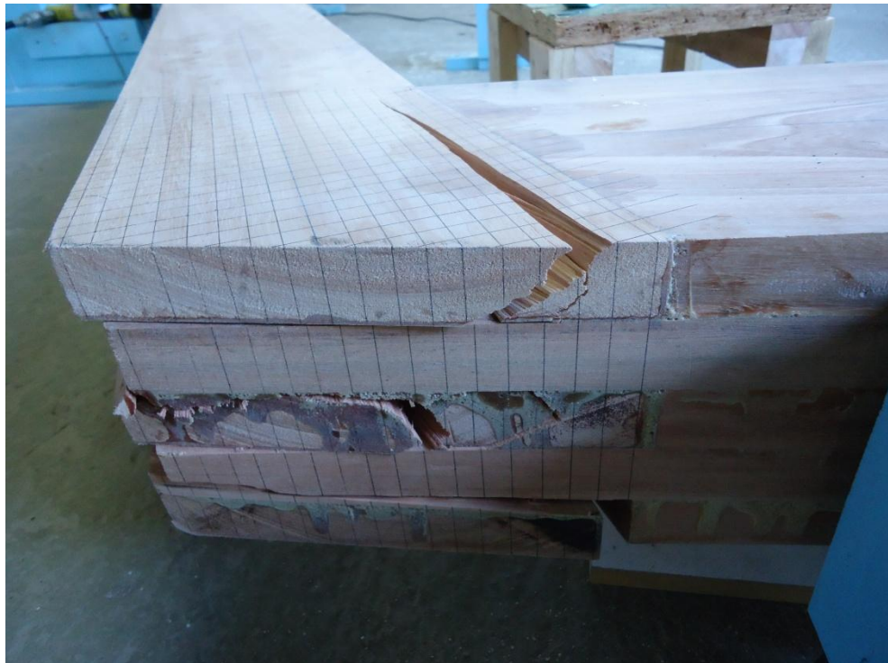
Figura 39 - Detalhe da ruptura ocorrida na região do nó B da estrutura M1.
