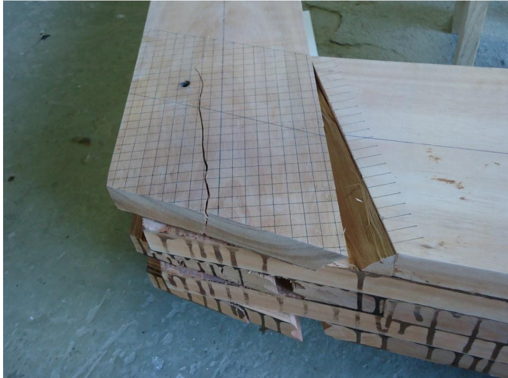
Figura 42 - Detalhe da ruptura ocorrida na região do nó B da estrutura R1.
