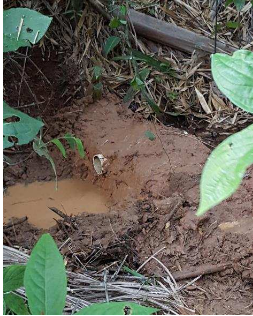
Figura 15. Barragem construída com a terra do local para medição pelo método volumétrico da vazão da nascente da microbacia da bacia do Rio São Mateus, MG.
