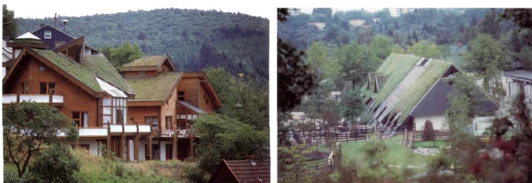
Figura 6 - Cobertura viva com 45° de inclinação, Siegen-Berlin (Alemanha). Fonte: KOLB e SCHWARZ (1999).
