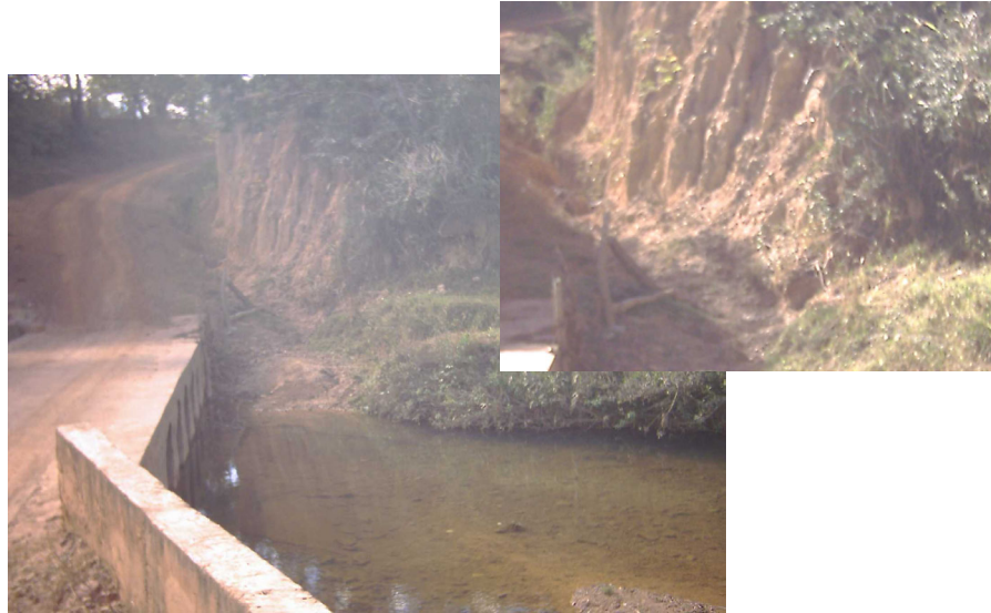
Figura 19 – Vista de talude com erosão em sulcos, provocada por enxurrada, que se direciona ao rio Guandu.
