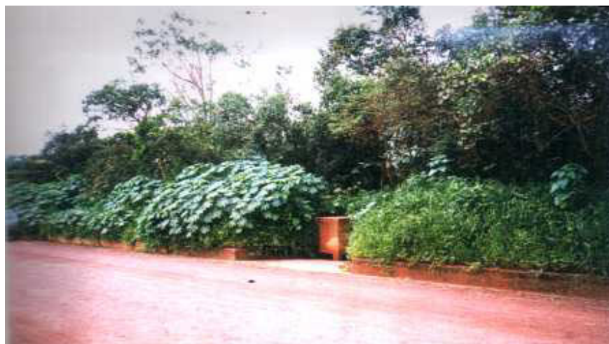
Figura 21 – Estrada de acesso à Somai Nordeste S/A, Alto Pacuí, Montes Claros, MG; notar as calhas para recolhimento da água das chuvas e o local apropriado para o deságüe.
