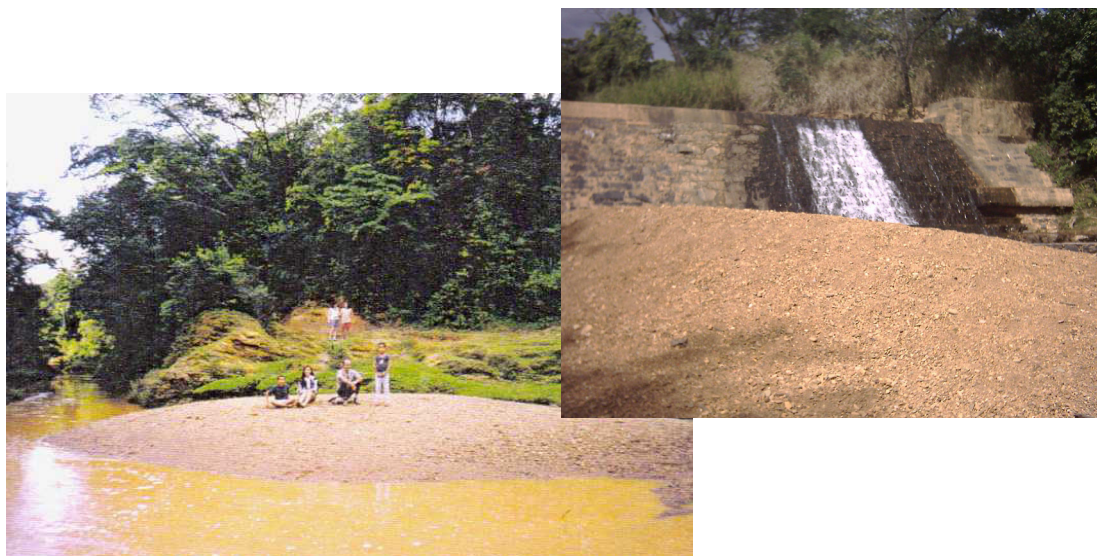
Figura 11 – Assoreamento – banco de areia – no alto rio Pacuí, a jusante da barragem; a tonalidade e a turbidez da água são também conseqüências da erosão do solo.
