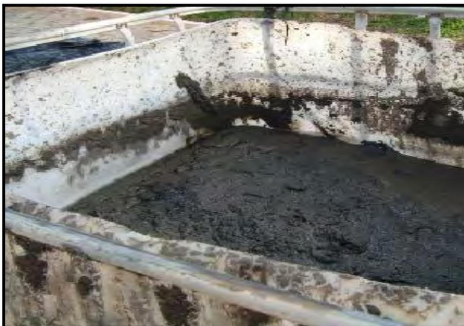
**Figura 15** – Lodo biológico proveniente do sistema de lodo ativado da fábrica de polpa celulósica.
